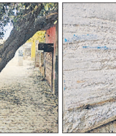
गन्जौर। निर्माणाधीन अगवानपुर ओवरब्रिज के सर्विस रोड के बीचों-बीच खड़ा पेड़।
