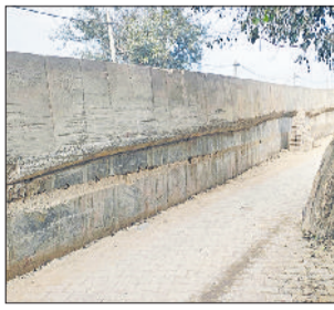
गन्जौर। निर्माणाधीन अगवानपुर ओवरब्रिज के सर्विस रोड के बीचों-बीच खड़ा पेड़।
